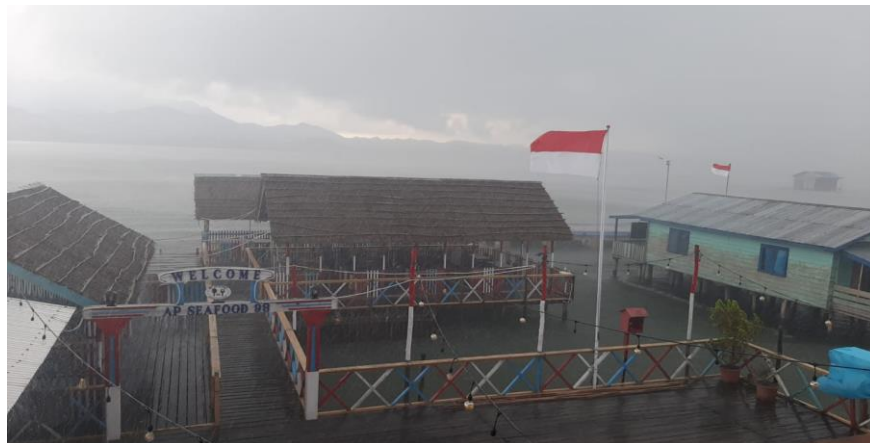
Gambar 2 Potret salah satu pemukiman warga yang didominasi material kayu
