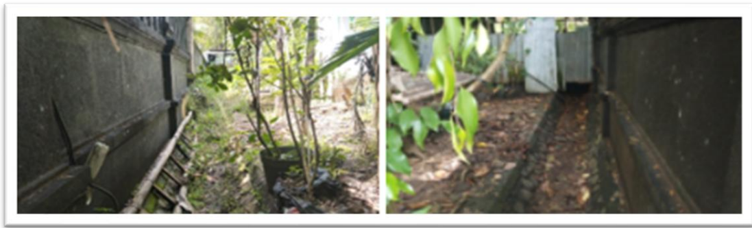
Gambar 2 Saluran Penuh Sedimen
