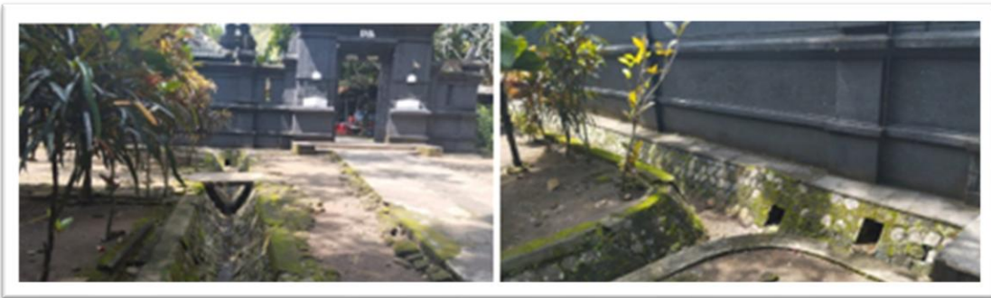
Gambar 2 Saluran Penuh Sedimen
