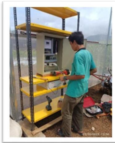
Gambar 4. Pemasangan panel surya untuk operasional screen house
