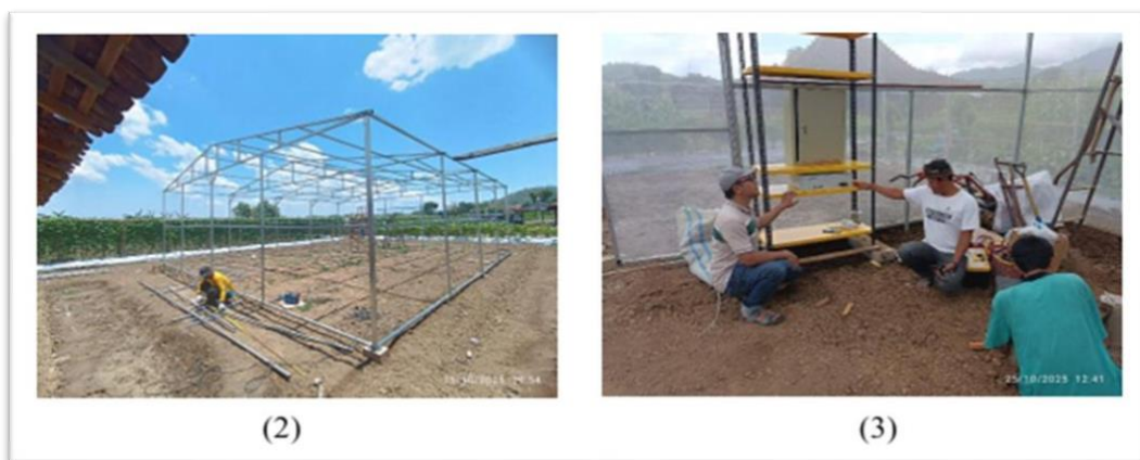
Gambar (2) Pembangunan screen house di lahan Barro Tani (3) Instalasi sistem irigasi tetes IoT dan sensor kelembapan tanah
