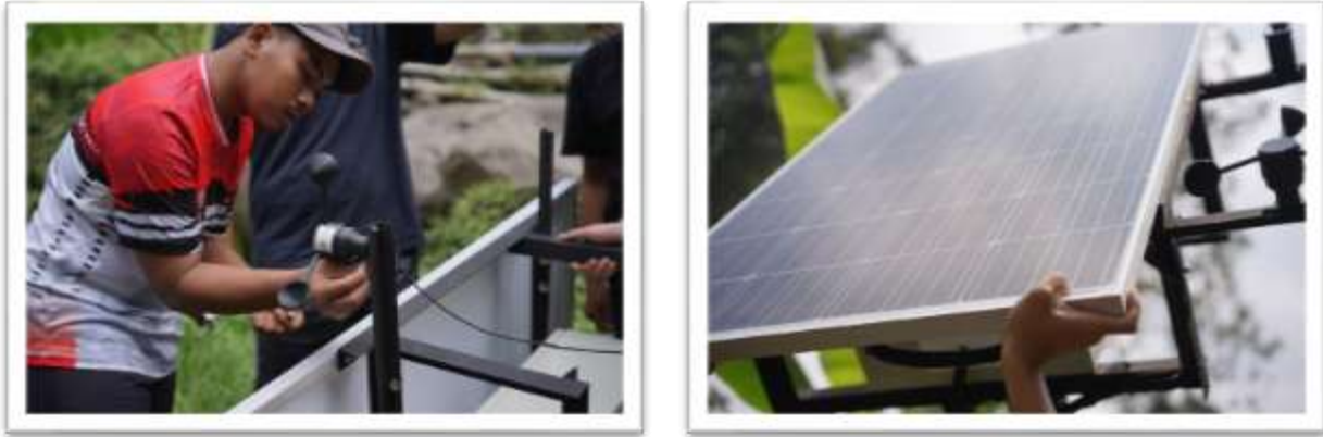
Gambar 2. Proses Pemasangan Alat Sensor dan Panel Surya pada Titik Strategis Aliran Sungai Banyumaro.
