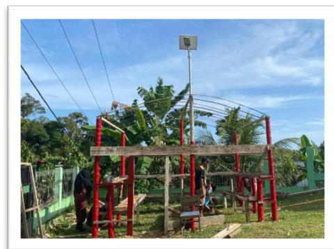
Gambar 4. Pengecatan Tiang, Rak, dan Kerangka Greenhouse
