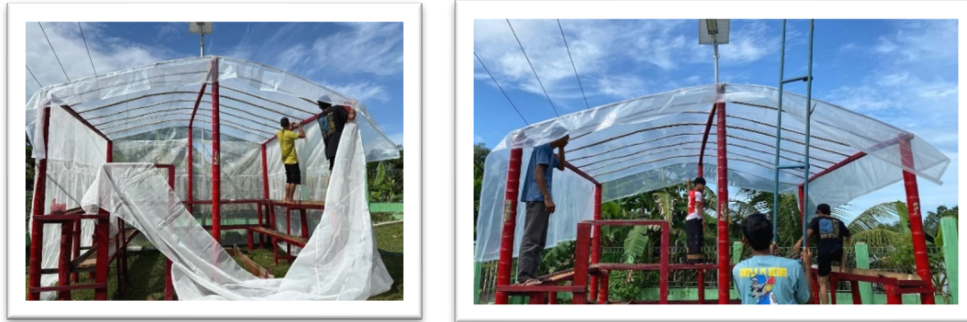
Gambar 5. Pemasangan insect net (kiri), Pemasangan plastik UV (kanan)
