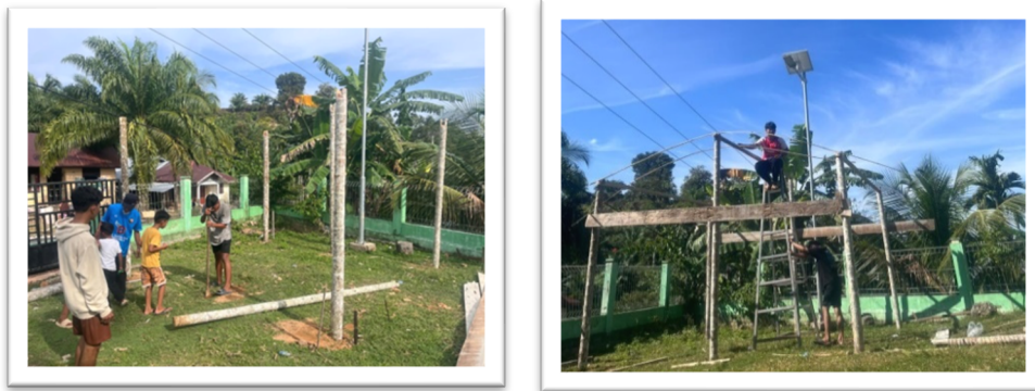
Gambar 2. Pemasangan tiang (kiri), Pemasangan rangka atap (kanan)
