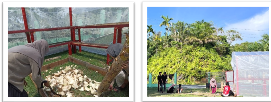
Gambar 6. Pembuatan bedengan (kiri), Pembuatan pintu dan pagar greenhouse (kanan)
