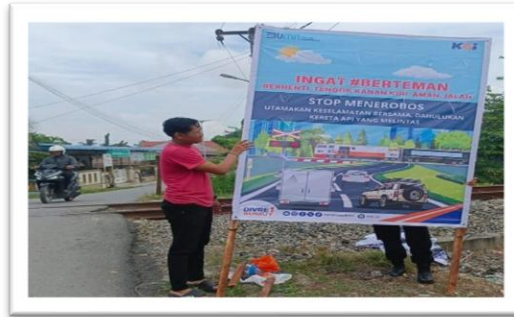
Gambar 5. Pemasangan Papan Peringatan Stasiun Binjai di Perlintasan
